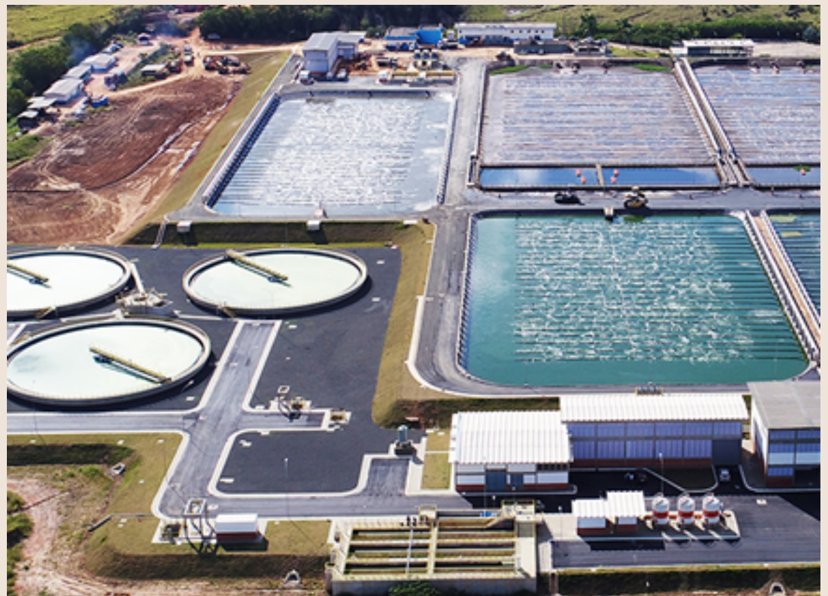
Estação de Tratamento de Esgoto (ETE) Indaiatuba Fonte: SAAE, 2020.
