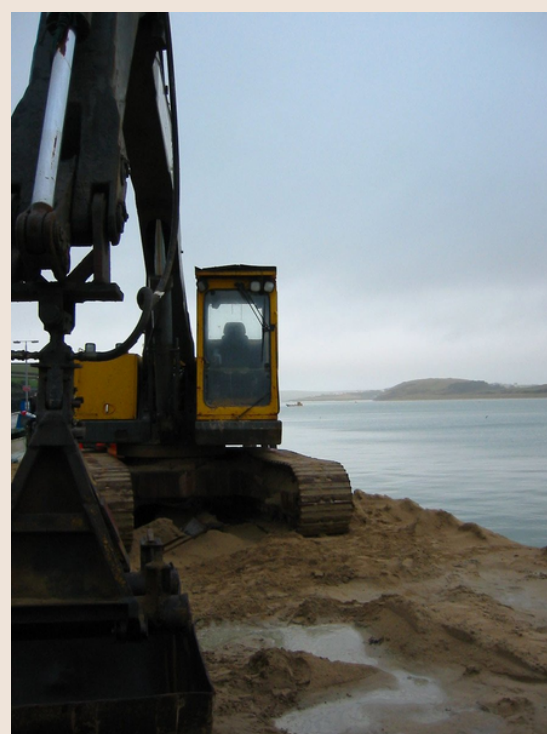
Remoção de sedimentos em canal e em rio
