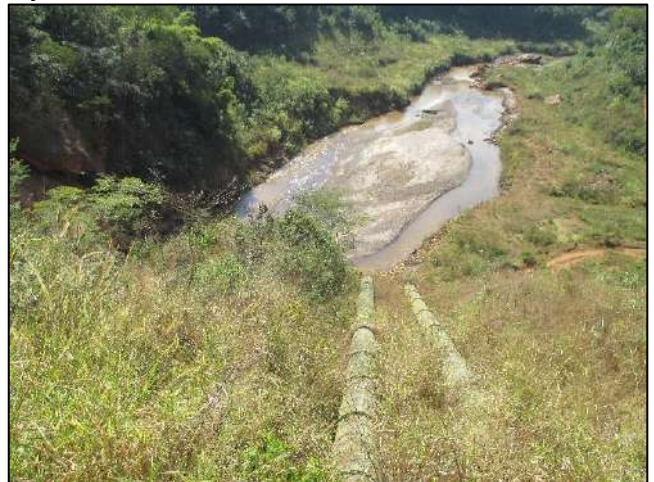
Foto 133: Detalhe do enroncamento e banco de rejeito
