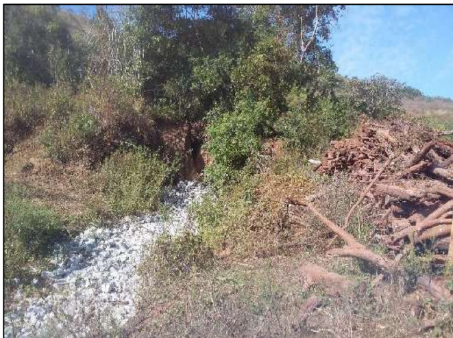
Foto 177: Canaleta de drenagem e deposito de madeira no trecho
