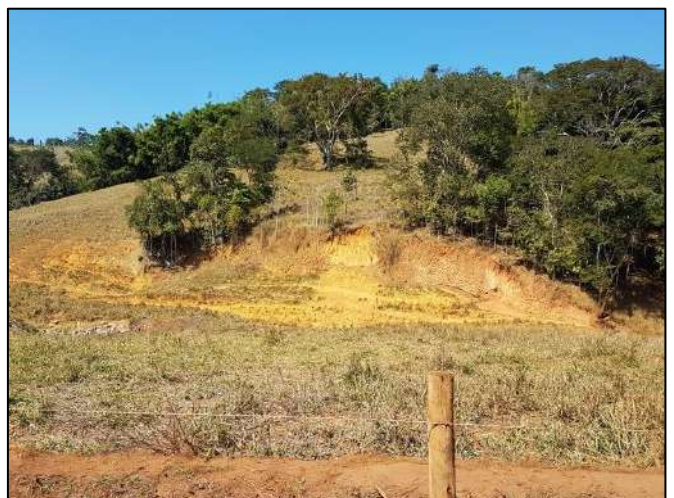
Foto 61: Talude coveado e com erosão na margem direita do rio Gualaxo do Norte
