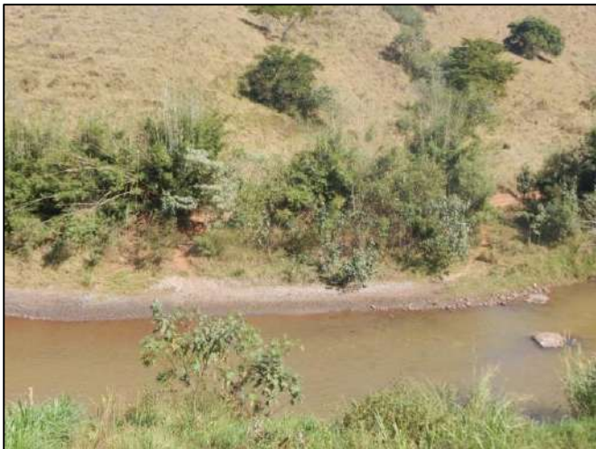
Foto 56: Ausência de cercamento na APP
