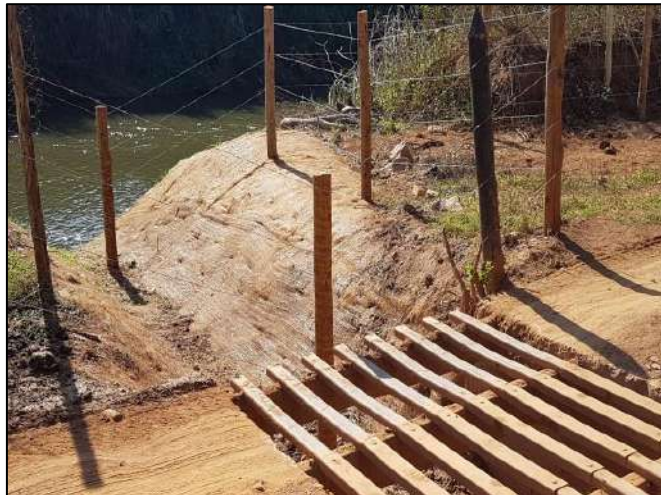
Foto 146: Obra de drenagem na margem
