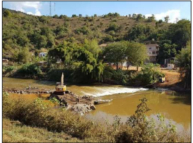
Foto 152: Trecho com obras no leito do rio do Carmo para retirada de constrições
