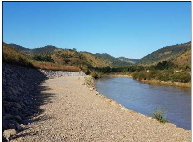
Foto 154: Trecho recuperado recentemente nas margens do Rio do Carmo. Foi constatado a presença de enrocamento e planície sem cobertura vegetal
