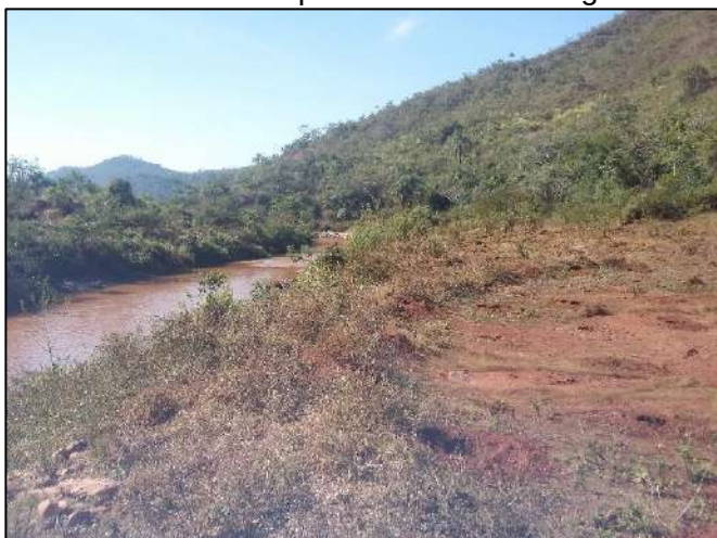
Foto 183: Área com problemas de drenagem
