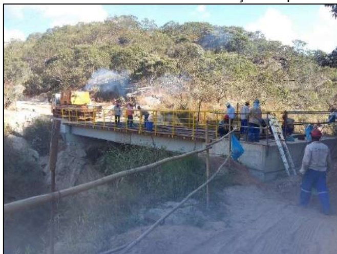
Foto 16: Trabalhos de reconstrução da ponte
