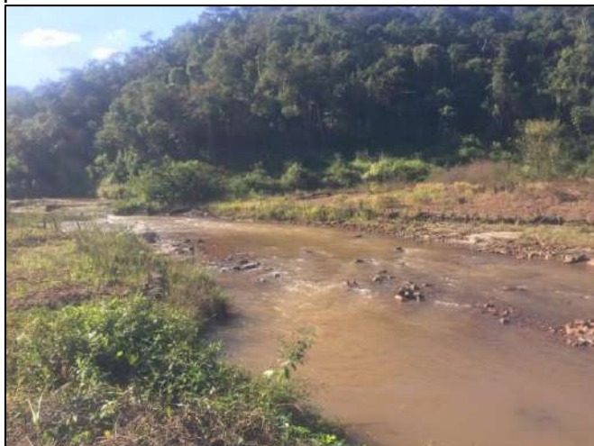
Foto 194: Obras de contenção nas margens e planícies
