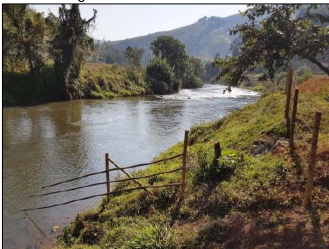
Foto 144: Reconformação e recuperação dos taludes marginais
