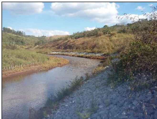
Foto 2: Enrocamento nas margens
