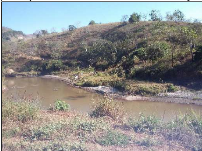
Foto 106: Praia de rejeito no rio, evidenciando a presença de afloramentos rochosos na margem
