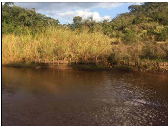
Foto 159: Margem direita do trecho, com retentores
