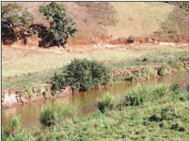
Foto 153: Processos erosivos na margem direita do Rio do Carmo
