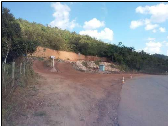
Foto 40: Obras de infraestrutura
