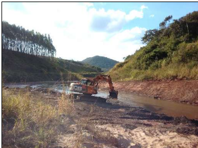
Foto 17: Máquina trabalhando na reconformação do talude
