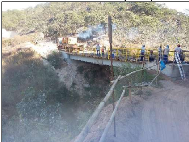
Foto 15: Trabalhos de reconstrução da ponte
