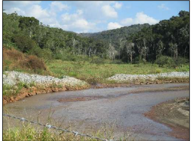
Foto 135: Detalhe do enroncamento e banco de rejeito
