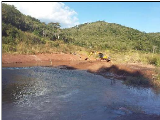
Foto 18: Máquina trabalhando na reconformação do talude
