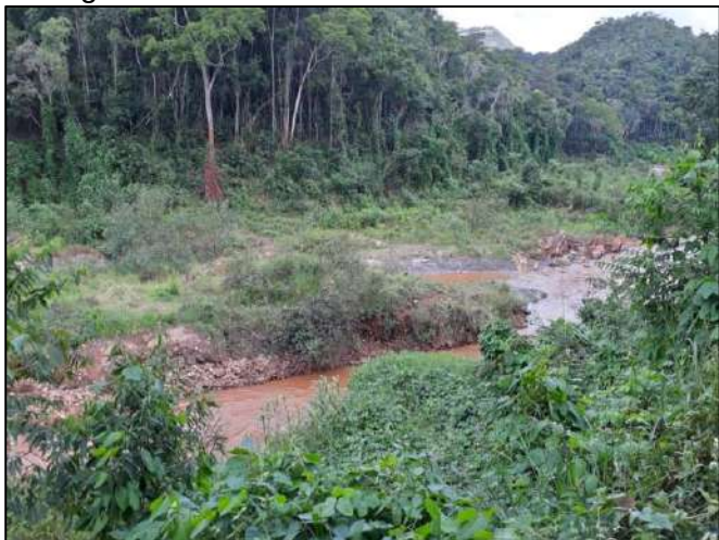
Foto 191: Ilha de rejeito, com ações de bioengenharia
