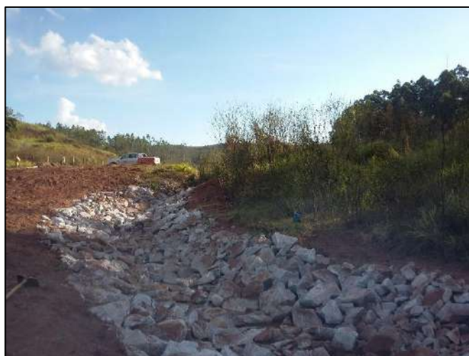
Foto 20: Canaleta de drenagem/tributário no ponto
