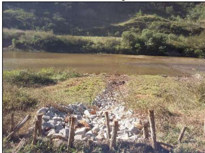
Foto 213: Canaleta de Drenagem
