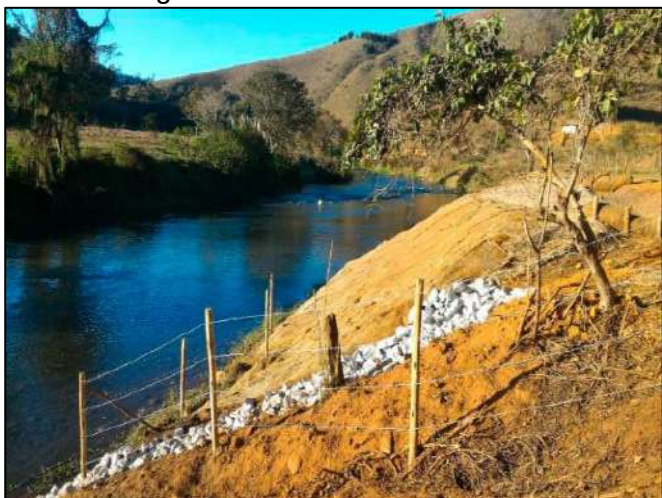
Foto 143: Reconformação e recuperação dos taludes marginais
