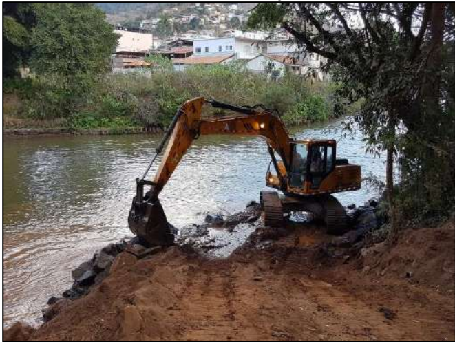
Foto 151: Trecho com obras no leito do rio do Carmo para retirada de constrições
