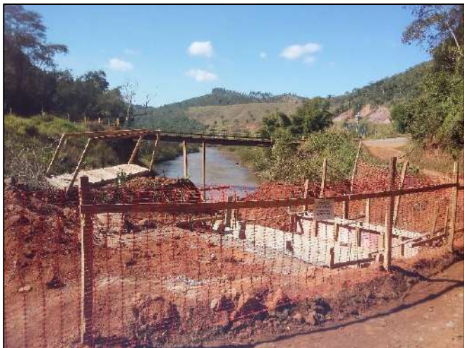
Foto 39: Obras de infraestrutura
