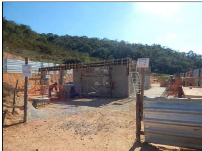
Foto 97: Reconstrução de casas no trecho
