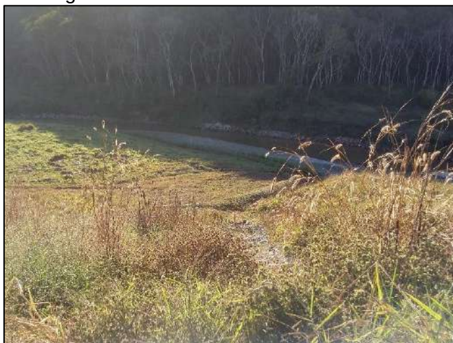
Foto 71: Vista panorâmica de um trecho da calha do Gualaxo do Norte, evidenciado o enrocamento na margem
