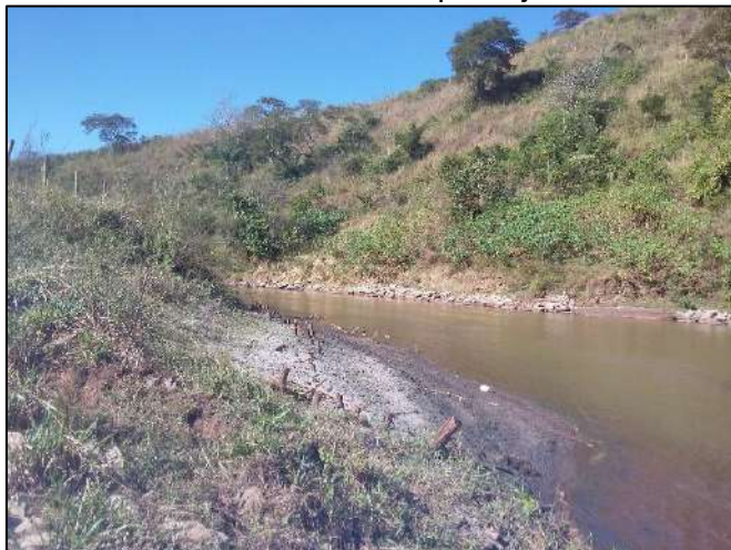
Foto 111: Retentor recoberto por rejeito
