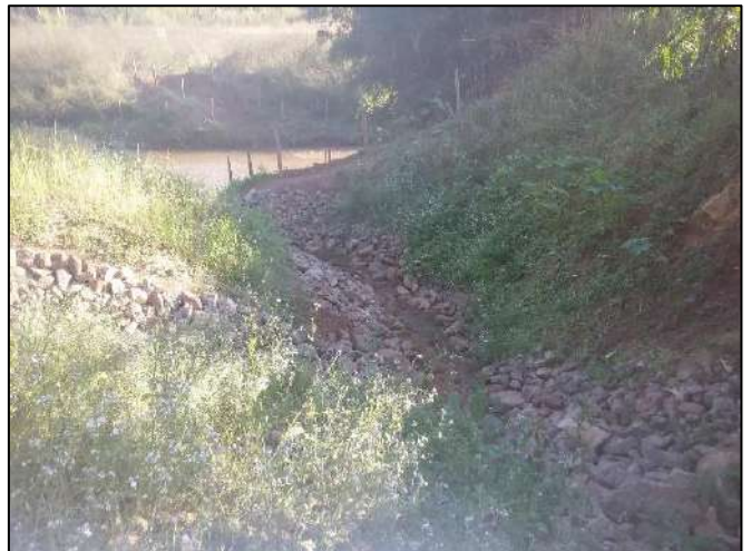
Foto 79: Tributário reconformado no trecho
