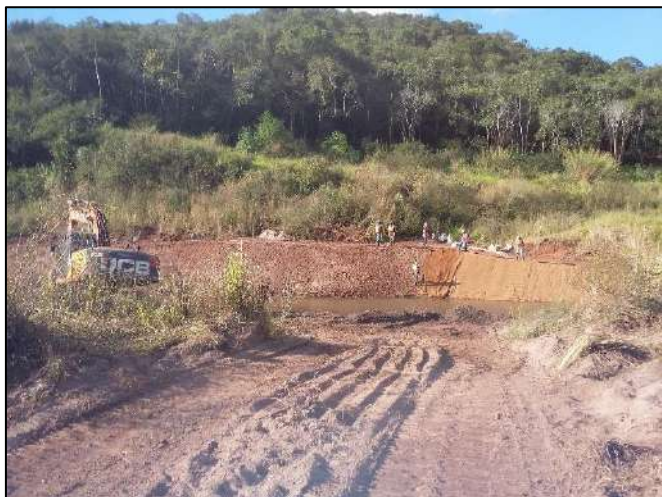
Foto 19: Trabalhos de bioengenharia na margem direita
