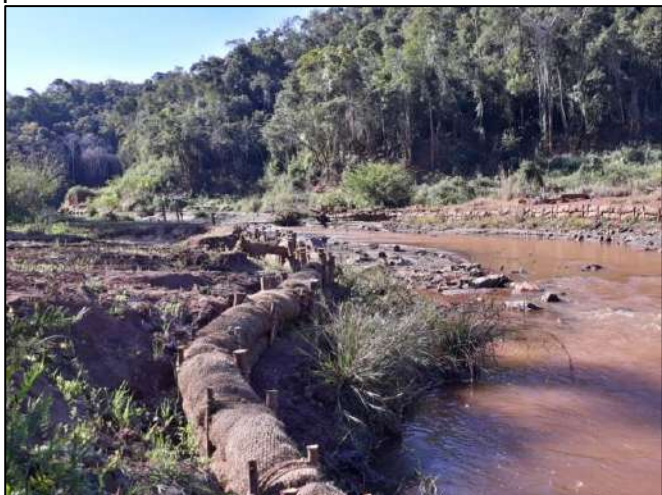
Foto 193: Obras de contenção nas margens e planícies
