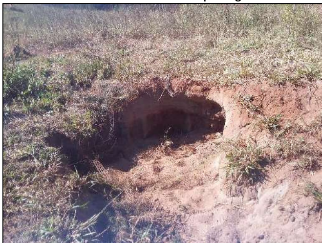
Foto 109: Biomanta danificada pelo gado
