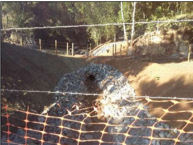
Foto 78: Tributário reconformado no trecho
