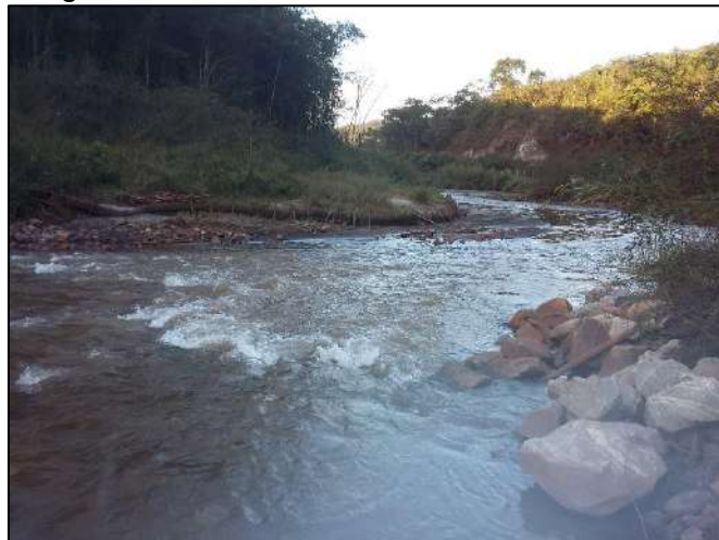
Foto 205: Bermalongas e enrocamento das margens
