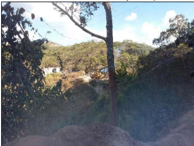
Foto 14: Trabalhos de reconstrução da ponte
