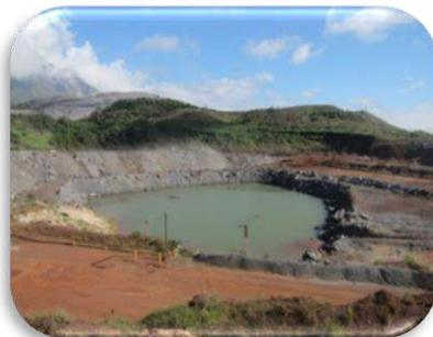
Material estéril sendo disposto na PDE 2, inserida sobre a barragem dos Patos
