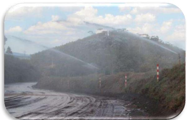
Imagem ilustrativa do sistema de aspersores fixos previstos para serem instalados na estrada de ligação entre as cavas São Luiz e Almas / Tamanduá
