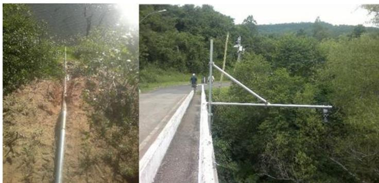
Figura 7: Tubulação de proteção do sensor de nível d'água: tipo transdutores de pressão, à esquerda (Estação Passo dos Farrapos, RS) e radar ultrassônico, à direita (Estação Picada Café, RS)
