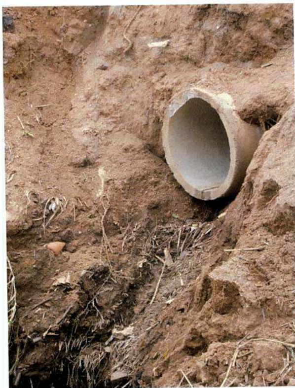
Imagem 02: rede de drenagem que abastece o açude.
