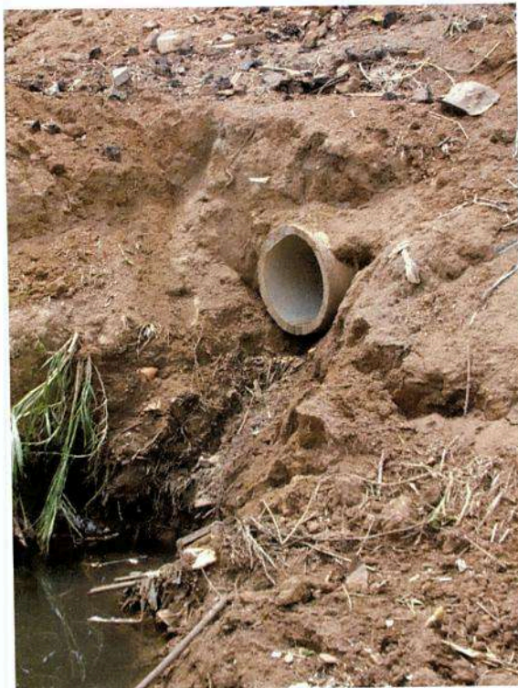
Imagem 01: rede de drenagem que abastece o açude.
