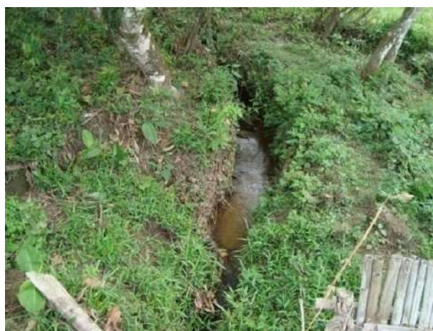
Figura 32 - Ponto de lançamento de esgoto da localidade rural Vargem da Imagem (Liberdade).
