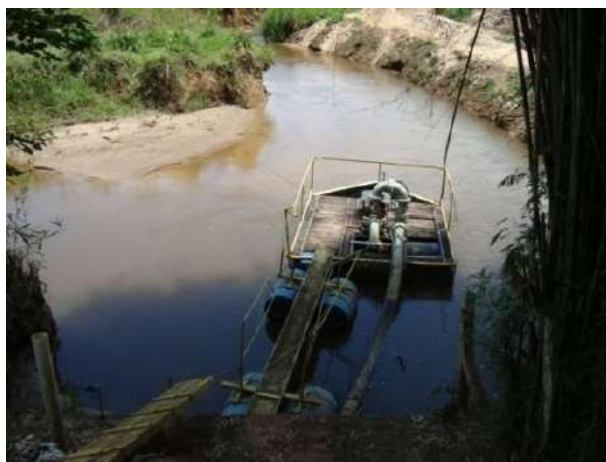
Figura 27 – Em destaque a balsa de captação para abastecimento doméstico da sede municipal de Carvalho (rio Francês).
