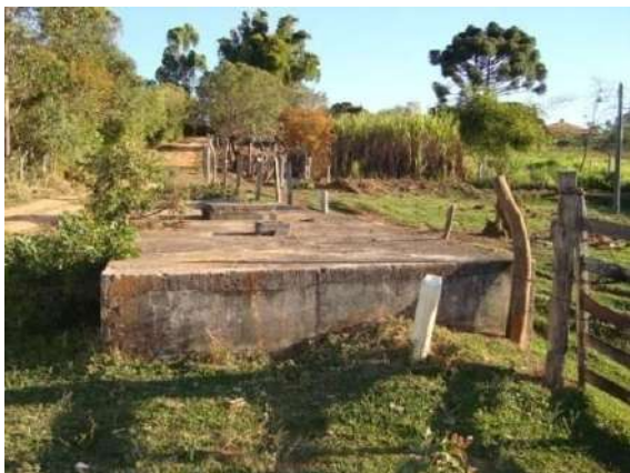
Figura 96 - Estação de tratamento de esgoto da localidade rural Jardim (Piedade do Rio Grande).
