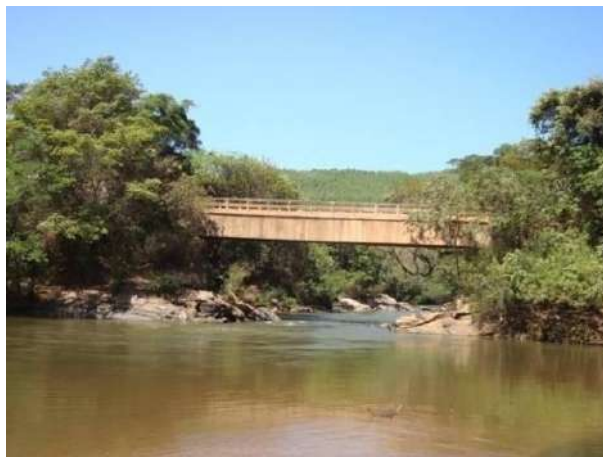
Figura 78 - Ponto destinado a recreação reprimido pelo lançamento de efluentes domésticos da sede municipal de Santana do Garambéu.
