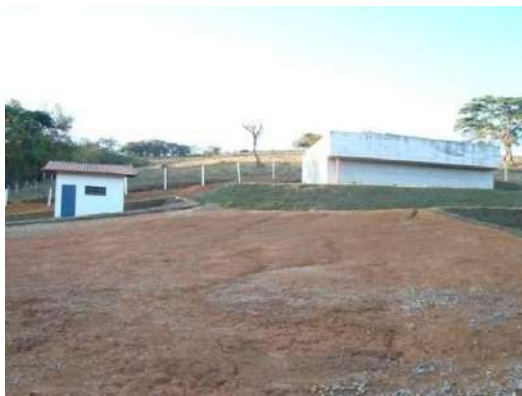
Figura 100 - Em destaque a estação de tratamento de efluentes do município de Piedade do Rio Grande.
