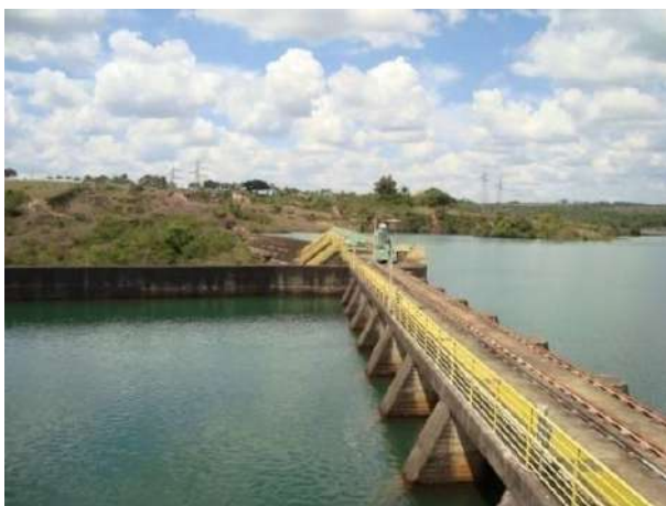
Figura 119 - Barramento Usina Hidrelétrica de Itutinga.
