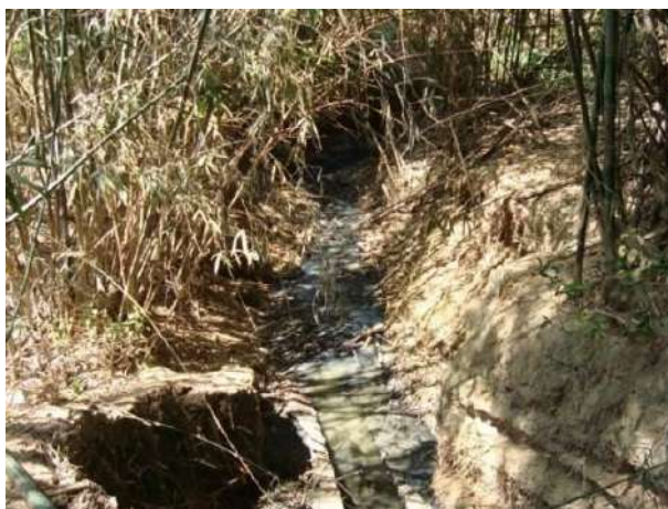
Figura 105 - Ponto de lançamento de esgoto tratado do município de Madre de Deus de Minas.
