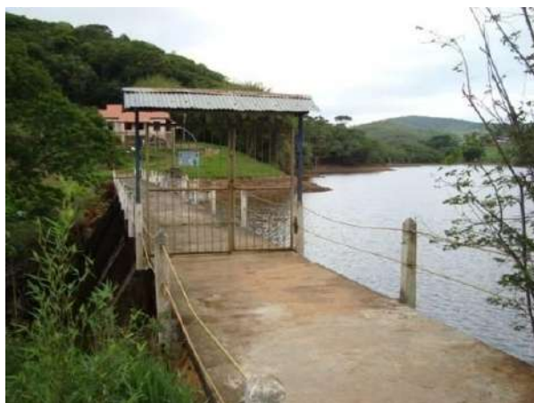
Figura 30 - Barramento PCH Barulho.
