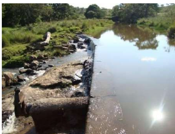
Figura 72 - Ponto de captação para abastecimento público da sede municipal de Itumirim.
