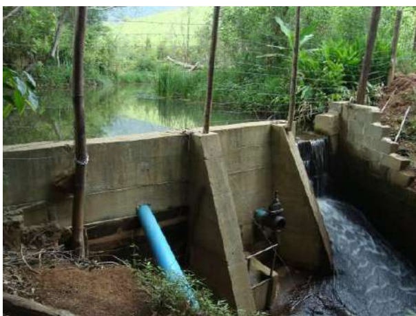
Figura 20 - Ponto de captação para o abastecimento público da sede municipal de Aiuruoca.
