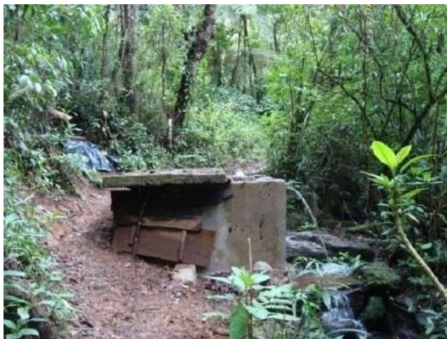
Figura 82 - Ponto de captação para abastecimento doméstico da sede municipal de Bocaina de Minas.
