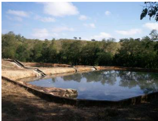
Figura 123 – ETE Rio Grande.
