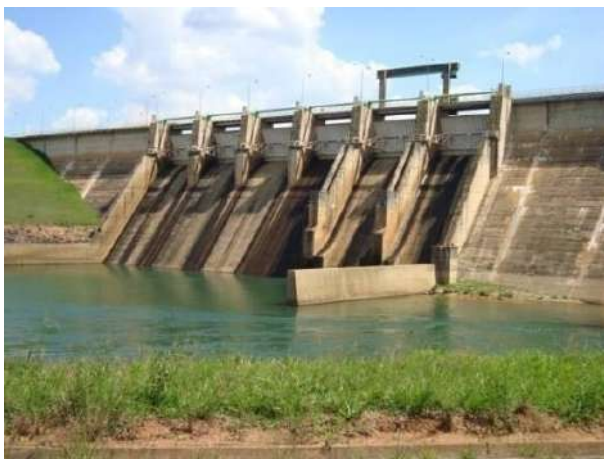
Figura 117 - Barramento da Usina Hidrelétrica de Camargos.
