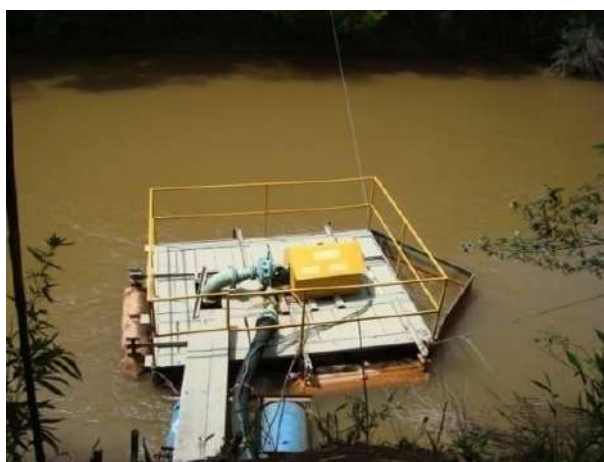
Figura 7 – Detalhe para a balsa de captação para abastecimento doméstico da sede de São Vicente de Minas (rio Aiuruoca).
