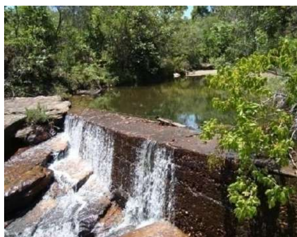
Figura 69 - Ponto de captação para abastecimento doméstico e industrial da sede municipal de Carrancas.
