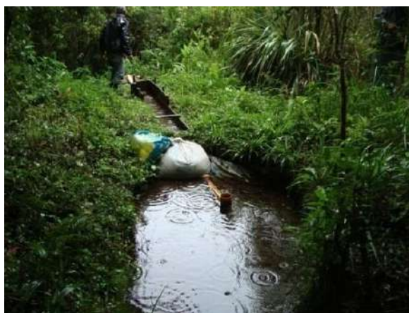
Figura 79 - Ponto de captação para abastecimento público do povoado rural de Santo Antônio do Rio Grande (Bocaina de Minas).
