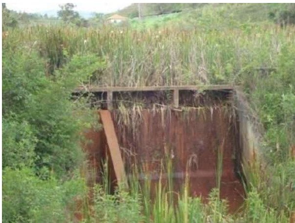
Figura 38 - Barramento do reservatório destinado a captação para abastecimento doméstico da sede municipal de Seritinga, local tomado por vegetação aquática emergente e bastante assoreado.
