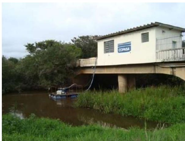
Figura 74 - Captação para abastecimento doméstico e industrial da sede municipal de Liberdade.
