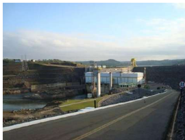
Figura 159 - Usina Hidrelétrica Funil.
