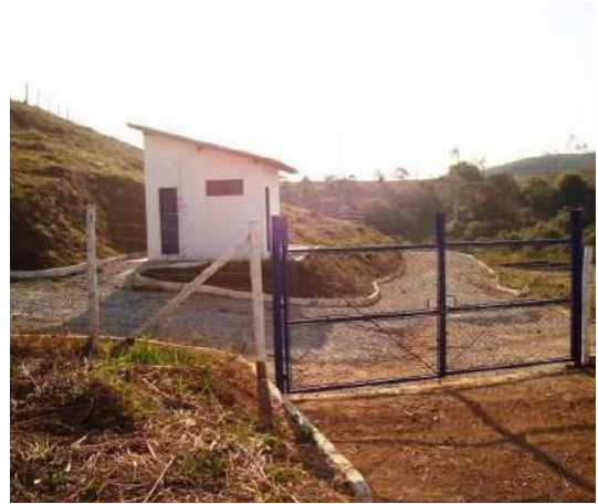
Figura 44 - Estação de tratamento de esgoto de Ressaquinha.
