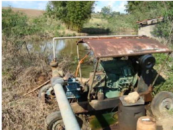
Figura 164 - Ponto de captação para irrigação por aspersão.
