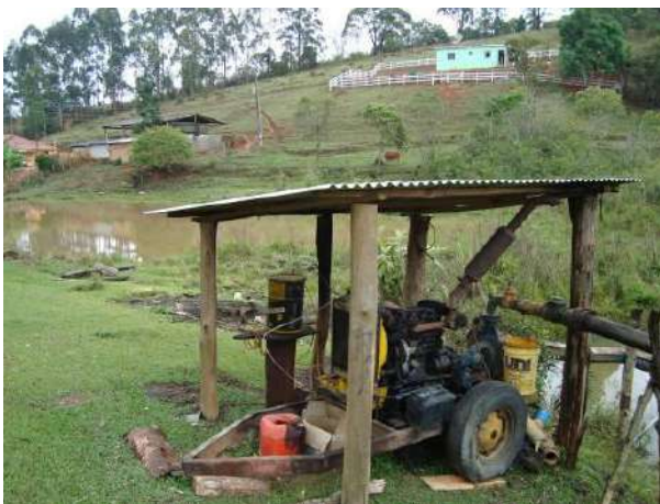
Figura 70 – Captação para a irrigação de olerícolas.
