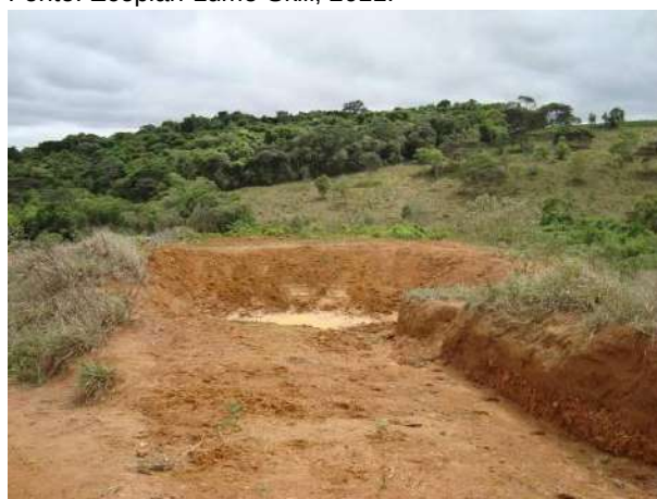
Figura 187 - Pequena barragem construída à margem da estrada vicinal para o acúmulo de água pluvial e sedimentos.
