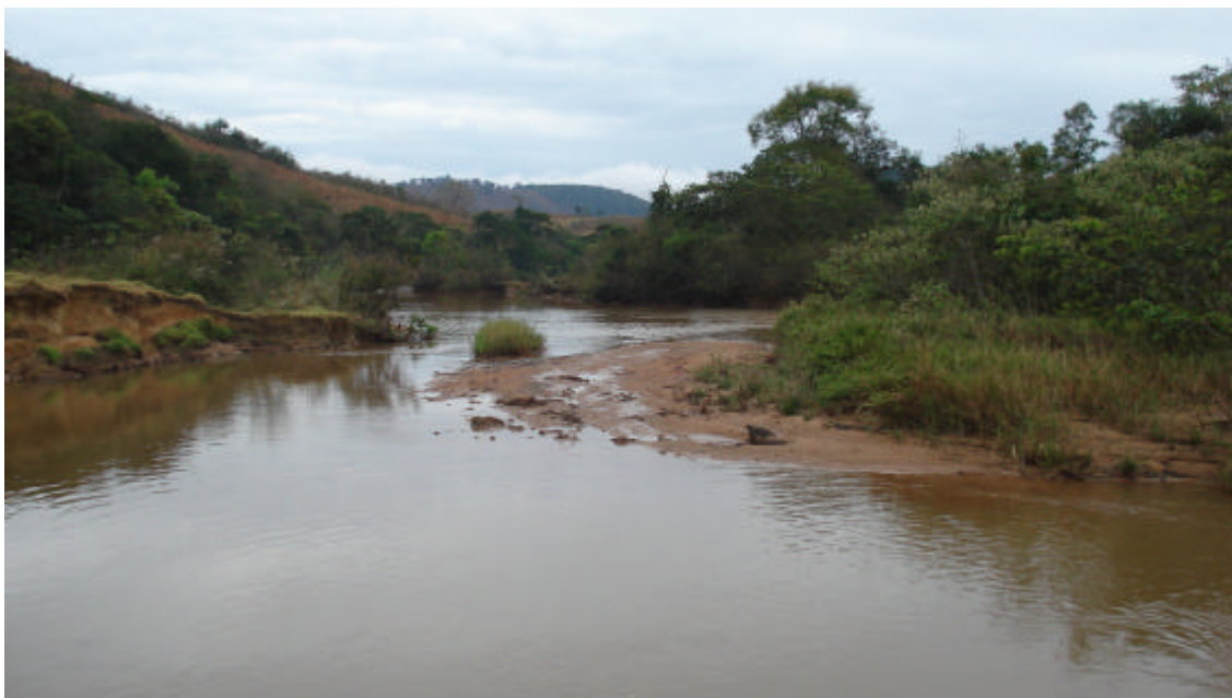
Figura 2: Futuro Trecho de Vazão Reduzida – TVR. Foto tirada do local do futuro barramento.
