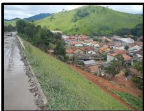
Foto 11. Moradias de alta vulnerabilidade construtiva e social, instaladas próximas ao talude de aterro da rodovia MG-158. Fonte: COMPDEC, 2024.
