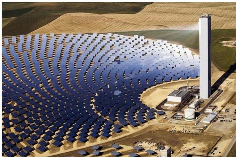
**Figura 3: Sistema de Torre Solar**
