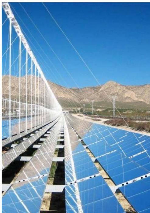
**Figura 5: Sistema Refletor Linear Fresnel**
