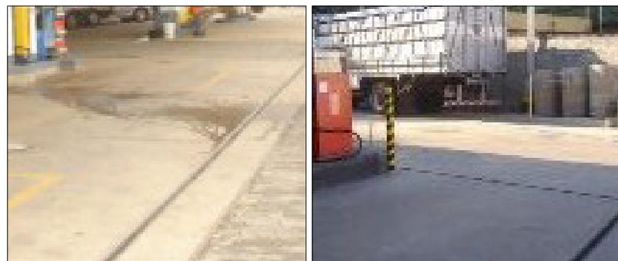
Calhas de segurança colocadas no piso impermeabilizado
