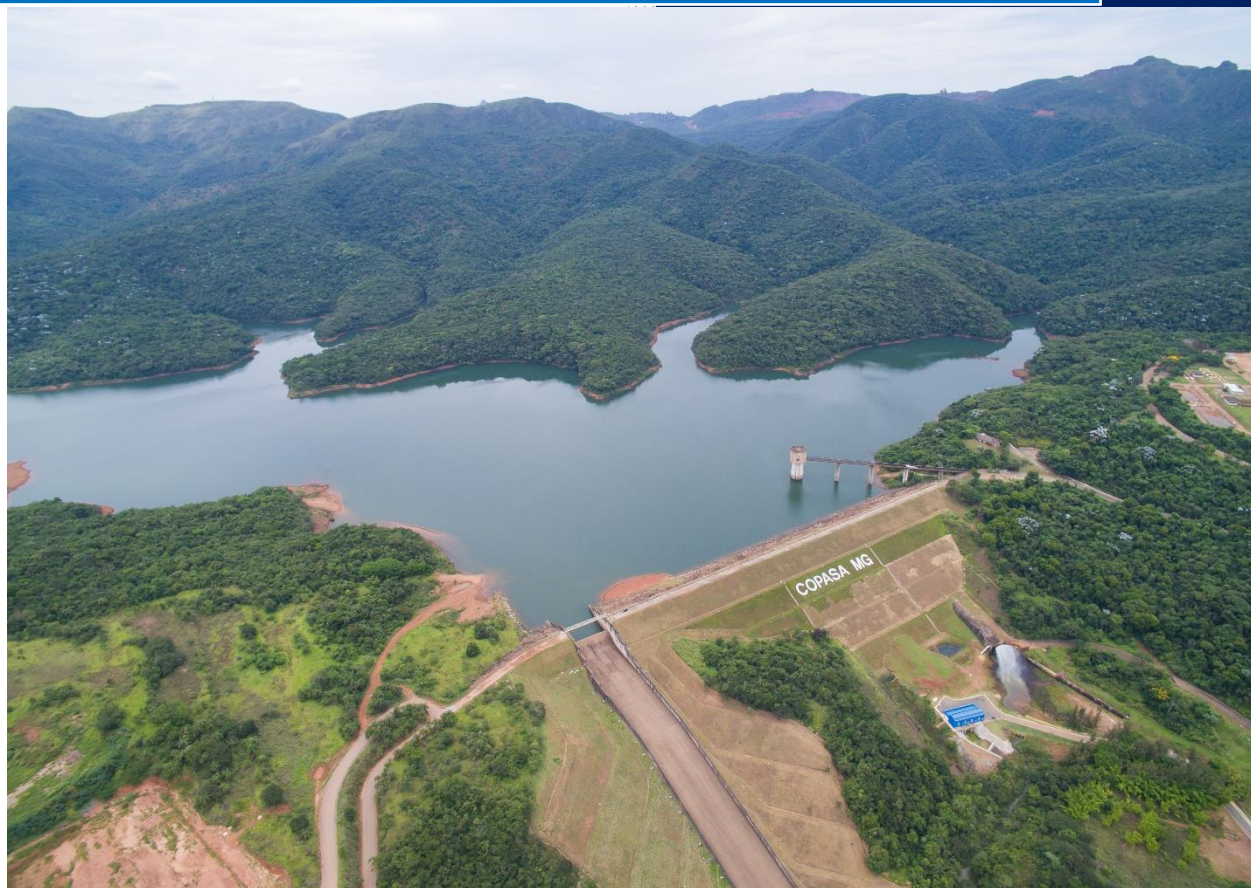
Barragem Rio Manso. Fonte: Arquivo Copasa.
